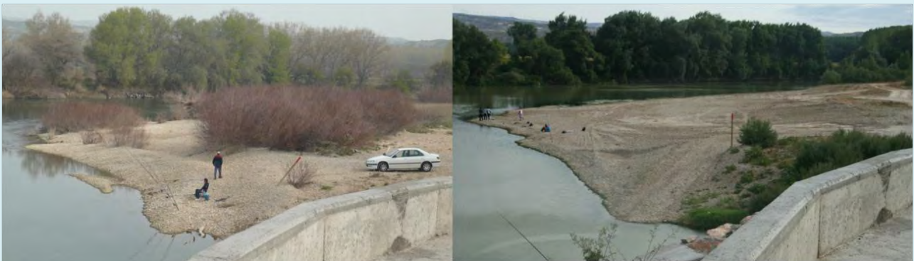
“Limpieza” del río Ebro en Cabañas en 2010: a la izquierda imagen de marzo, antes del dragado, y a la derecha imagen de agosto, posterior a la actuación. Fotos: A. Ollero.
