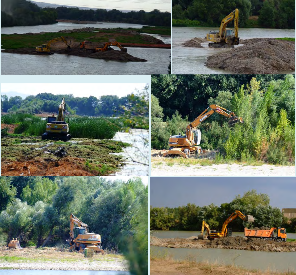
Distintas imágenes de las “limpiezas” realizadas, incluyendo la eliminación de una isla, en el río Ebro en Gallur en el verano de 2010. Fotos: J.A. Pinzolas.
